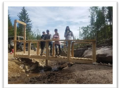
Réalisation d'une passerelle Parc régional des Sept-Chutes, 2018
